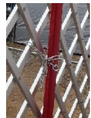
各ヶ所に門扉とポートで チェーンを巻き、南京錠等で 鍵すれば補強完了
