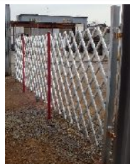
SCUT91打ち込み後 補強用単管ポールを差し込む ※【写真は2本立て】
