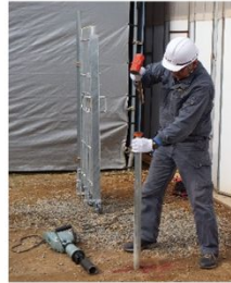
SCUT91をハンマー又は 杭打ち付け機で打ち込み
