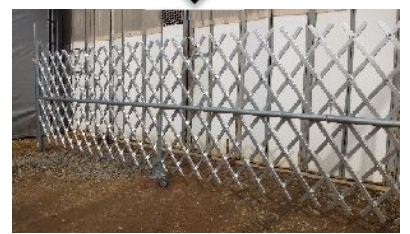
門扉を開いて、単管受けに 単管を取り付ける ※【今まではこれで完了】
