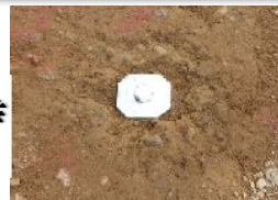
単管ポールを使用しない時は ゴミが入らない様にフタをします
