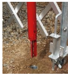
打ち付けたSCUT91の穴に 補強用単管ポールを差し込む
