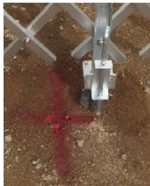
門扉を取付後、中心部に マーカールを入れる
