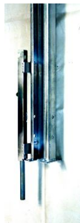
移動柱に溶接した状態
