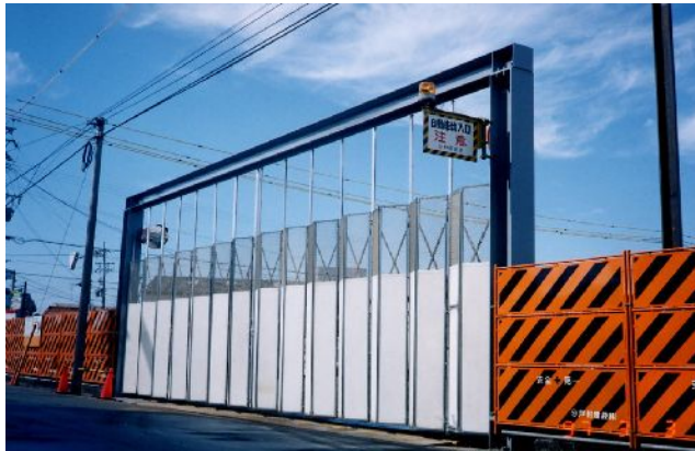
H4.7m × W12.0m ● 梁・柱をH鋼仕様
