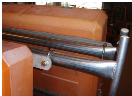
※分電盤を単管フックにて取付
