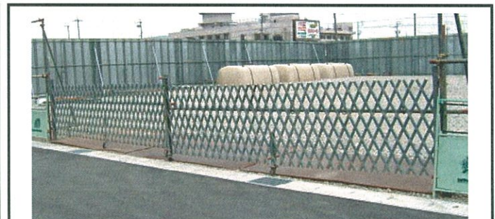
*写真上 ミニドアLM4.5m×2 (両開き仕様・単管に取付)
