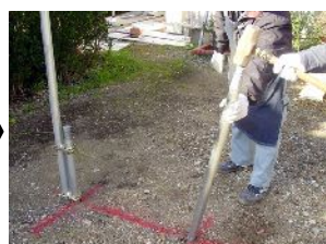
7. くい丸1.1mを60度ぐらいで打ち込む
