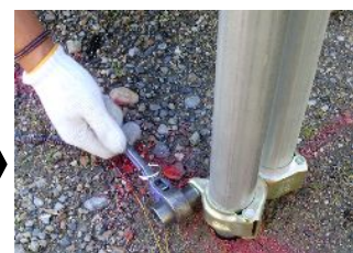
4. 自在クランプで単管1.5mを垂直に取り付ける
