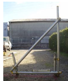
12. 単管設置完成
