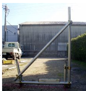
10. 単管1.5mを自在クランプでつなぎ補強する
